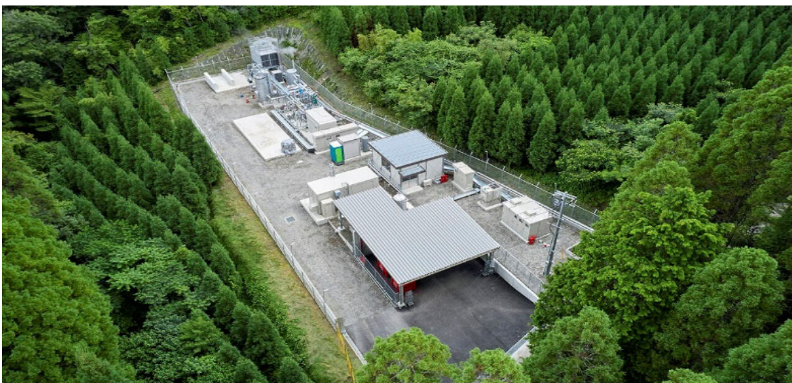
写真1. 地熱発電電力活用グリーン水素製造実証プラント全景
